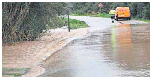
Un vehículo de Algesa en una zona inundada.
