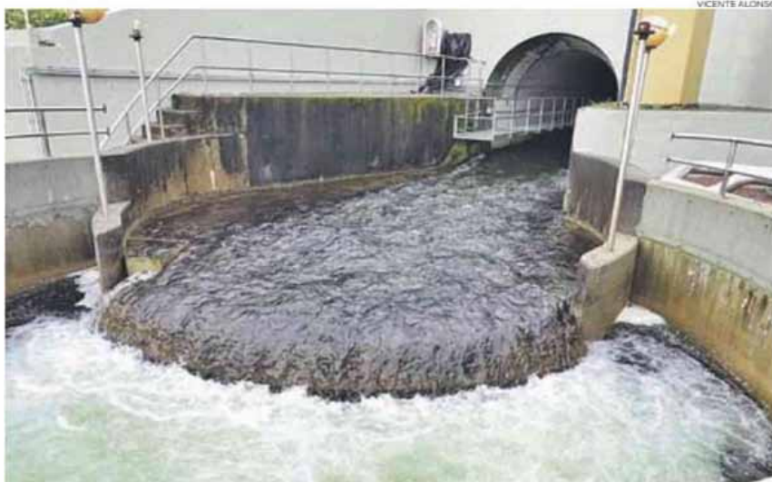
La llegada del suministro de agua a Vigo desde el embalse de Eiras.
